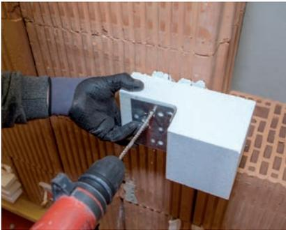
Unser hoch wärmedämmender Montageblock wird als Element des Vollwärmeschutzes direkt an der Wand befestigt. Nachdem Sie das WDVS System fertiggestellt haben, können die Klapp- oder Schiebeläden durch einfaches Einschrauben befestigt werden. Das ist ohne Vorbohren möglich.
