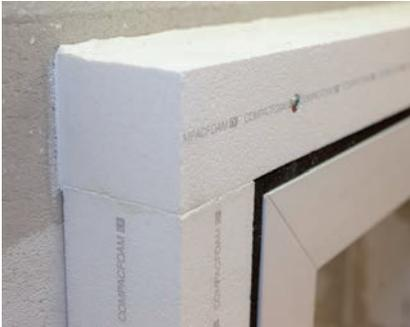
Mit dem KLIMA KONFORM SYSTEM 2.0 ist es möglich die Fenstereinheiten direkt in die Dämmebene zu integrieren. Somit sind wärmebrückenfreie Wandanschlüsse möglich.
